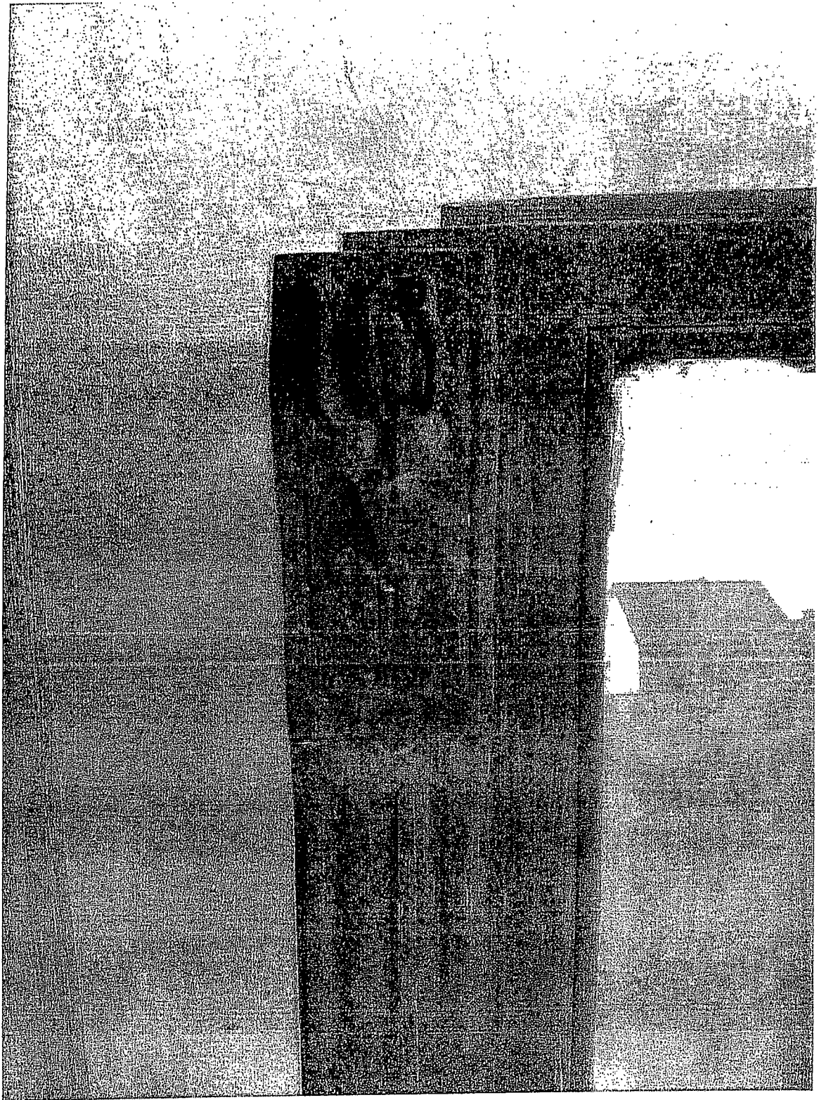
Ablakszárny felső része - felújított eredeti virág motívumos faragás
